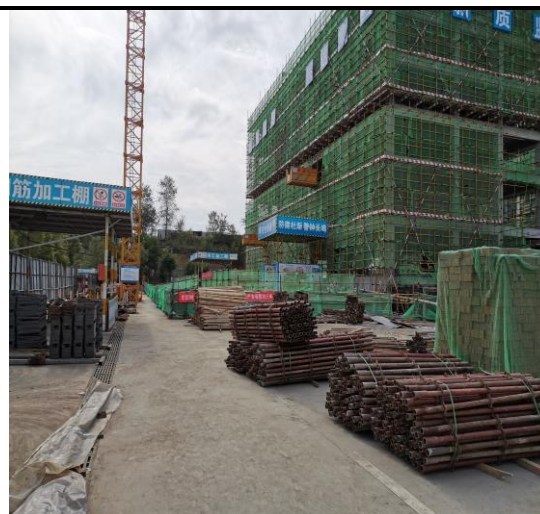
项目区主体工程
